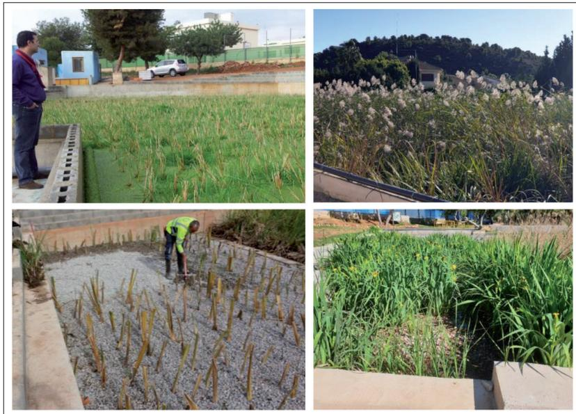
ficial vertical intensificado (60 m<sup>2</sup>), seguido de un humedal de flujo superficial (50 m<sup>2</sup>), muy similar a un humedal natural. La calificación 'intensificado' está relacionada con el material filtrante del humedal, que en lugar de ser la grava que habitualmente se utiliza, es un material adsorbente de fósforo y otros contaminantes. Este material es un residuo que se genera en las estaciones de tratamiento de agua potable (ETAP),
